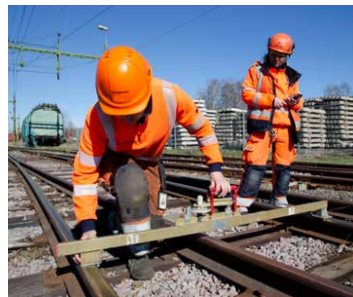
Mätning av säkerhetstoleranser i spårväxel. FOTO: TRAFIKVERKET
